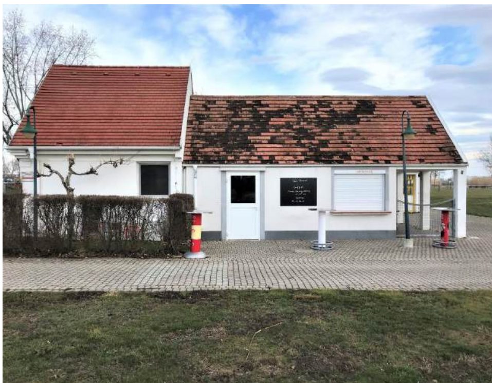
Ansicht Imbiss Südseite; Bereich, der außerhalb des Seebades liegt
